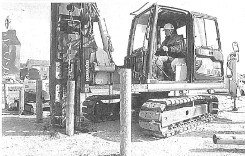
防腐・防蟻処理を施した円柱状の木くいを地中に入れる作業員。鉄鋼やコンクリートを使った地盤補強に比べ、環境負荷が低減できるという＝熊本市
